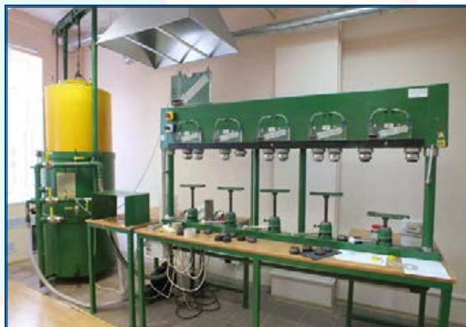
Установка для поверки газосчетчиков.
